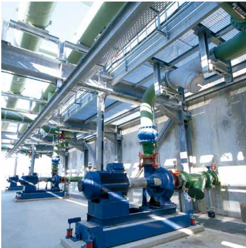
Système de ventilateurs aéroréfrigérants
