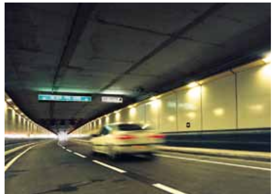
Assainissement de l'air et désenfumage dans un tunnel routier
