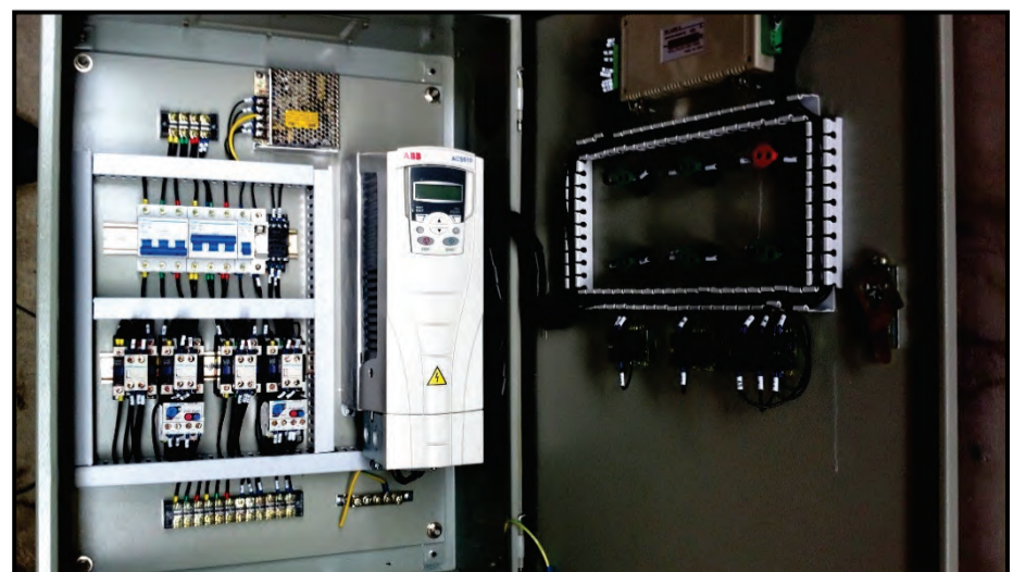
■ Réalisation et mise en service d'une armoire avec variateur ABB 22kW
