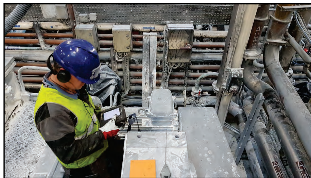
■ Analyse en cours d'une motorisation sur malaxeur
