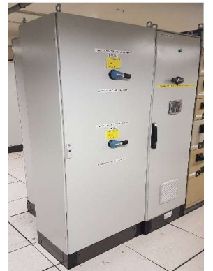
VARIATEUR ET ARMOIRE DE DISTRIBUTION
