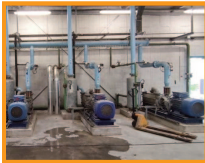
Remplacement de pompes à anneau liquide
